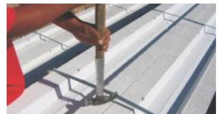
Fig. 4: Desflejado de paquetes de paneles.
