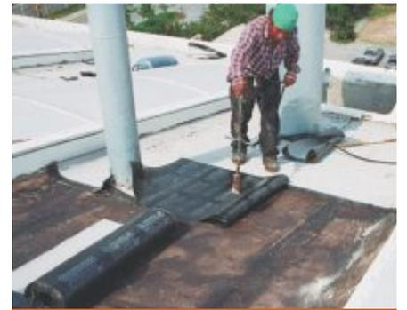
Fig. 22: Impermeabilización de membrana.
