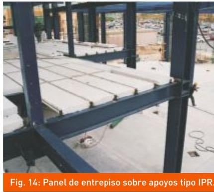
Fig. 14: Panel de entpiso sobre apoyos tipo IPR.
