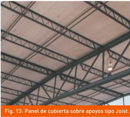
Fig. 13: Panel de cubierta sobre apoyos tipo Joist.
