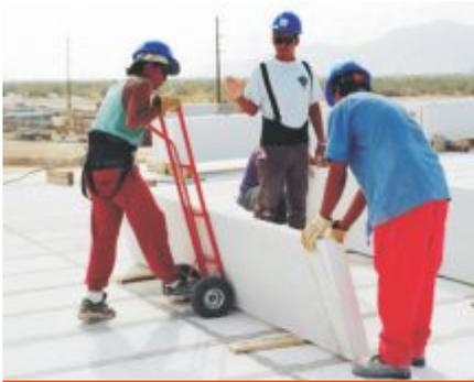
Fig. 5: Colocación del panel sobre el "diablito".
