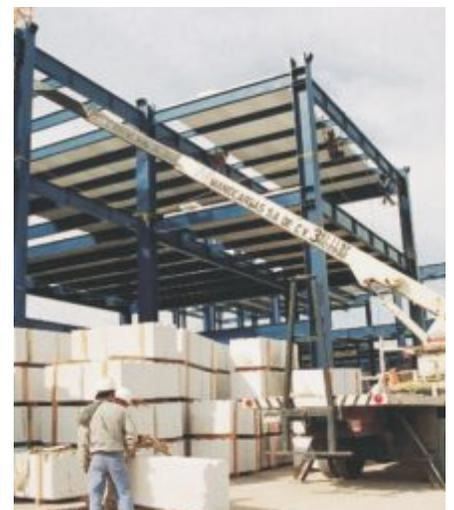
Fig. 2: Almacenamiento de panel Hebel en obra.
