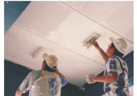
Fig. 23: Pasta acrílica en acabado inferior de panel Hebel
